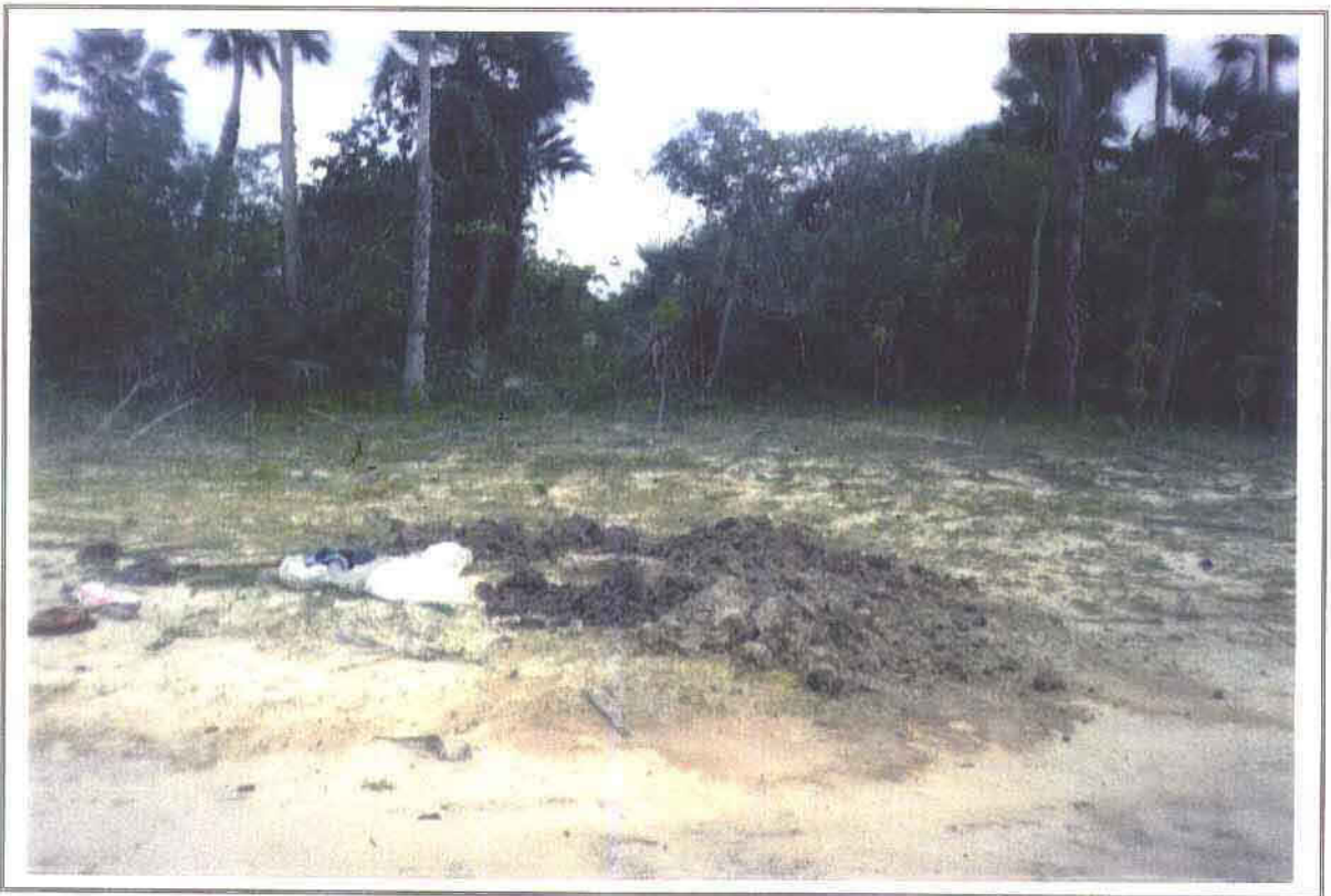
Foto 02 - Sondagem Pá e Picareta início da adutora.
